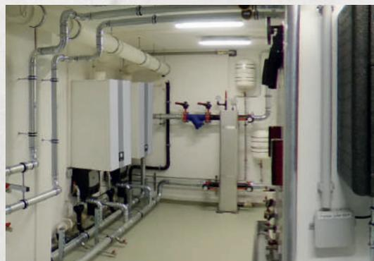
Cascadable jusqu'à 5 unités, ce qui assure une large gamme d'applications avec une puissance pouvant aller jusqu'à 500 kW.
