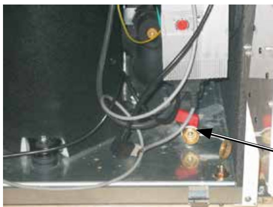
Zawór do napełniania i spustu w obiegu solanki
