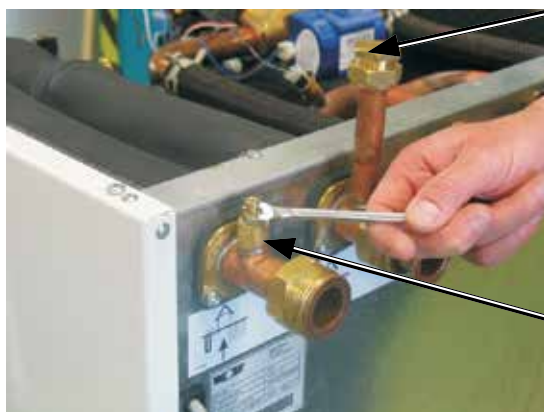
Ręczny odpowietrznik na dopływie solanki
